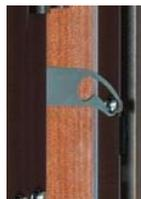
Limitador de Abertura: Fecho de segurança, que substitui a antiga corrente metálica e que, quando accionado, só permite a abertura parcial da porta.
